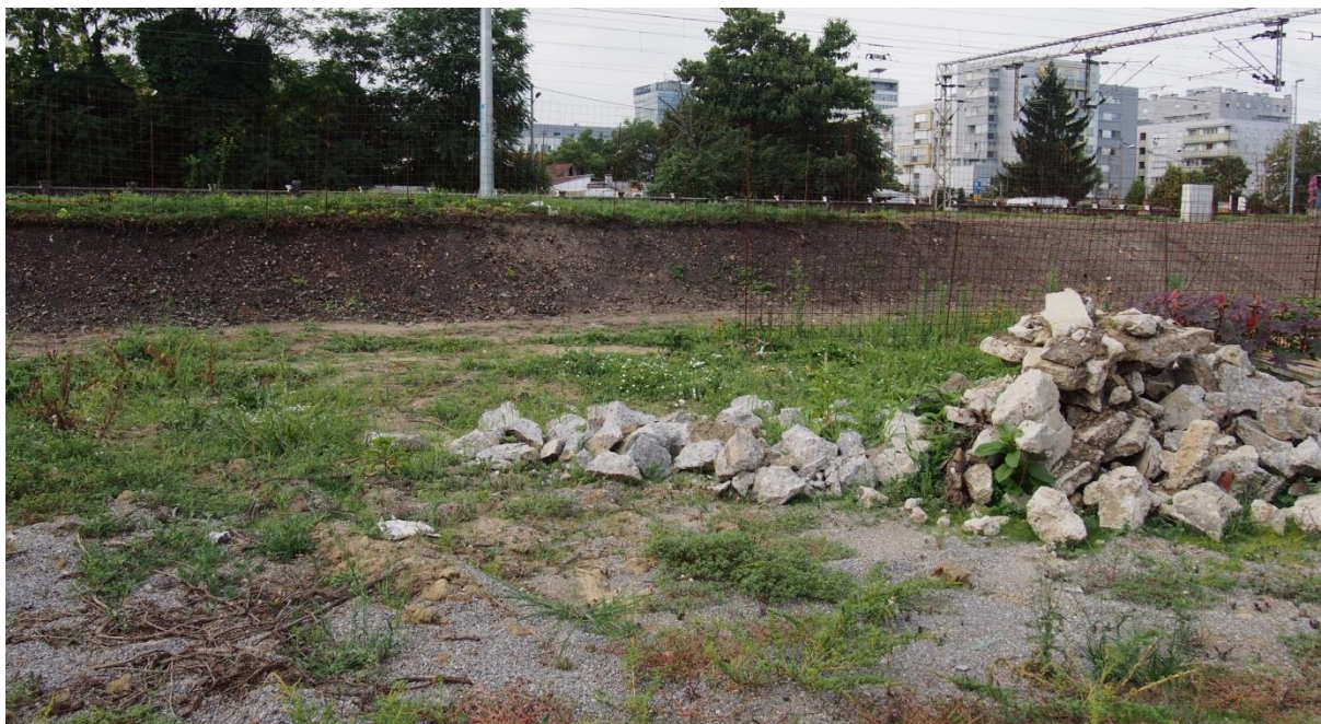
Slika 3-9 otvoreno gradilište na lokaciji
